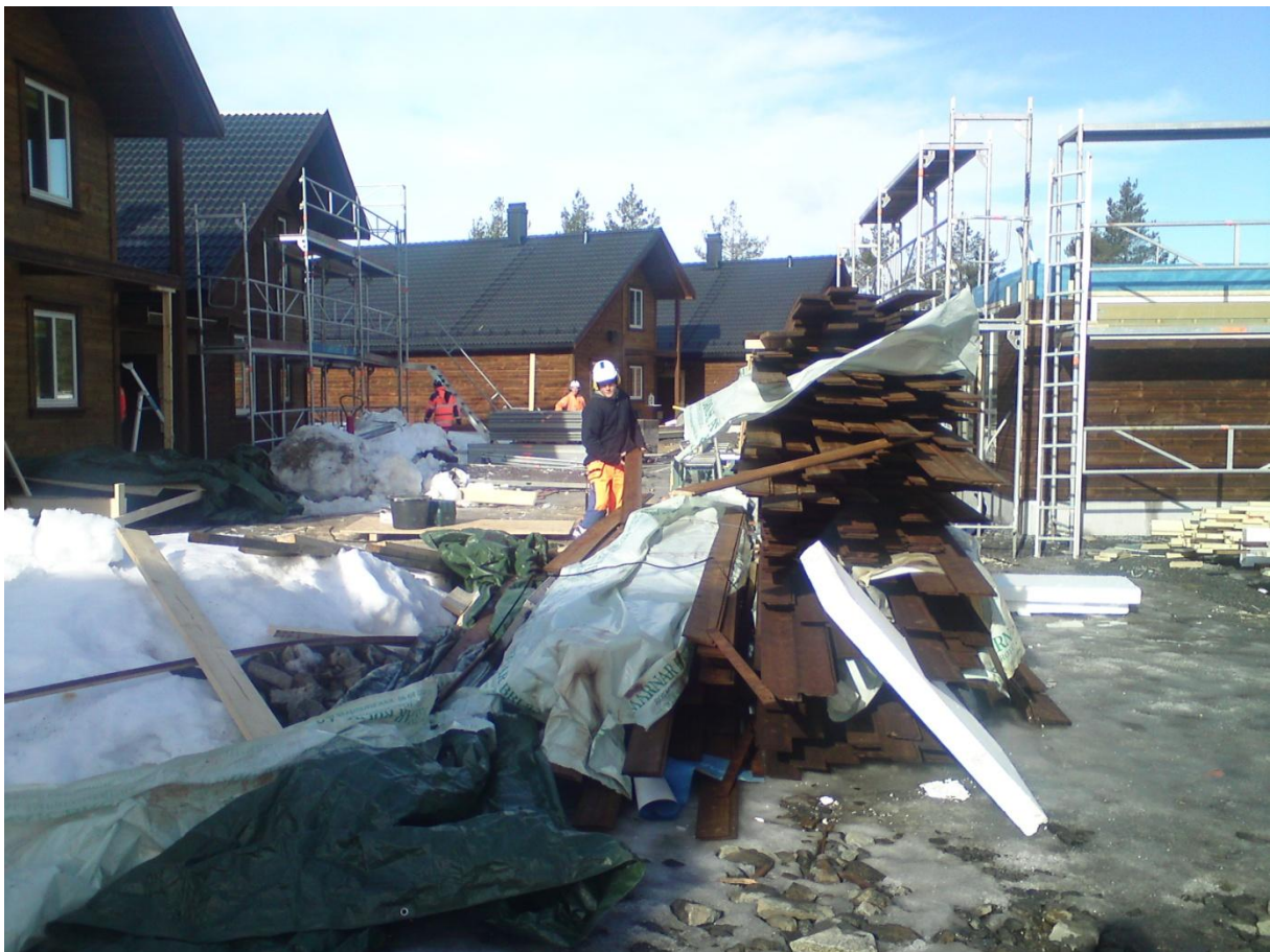
Figur 5-17. Mellomlager av kledning for flere av boligene.
