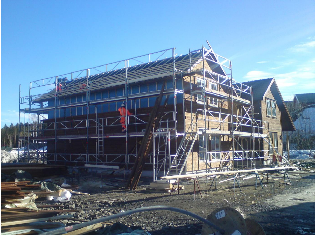
Figur 5-24. Arbeid i overliggende etasjer medfører økt tid til materialtransport
