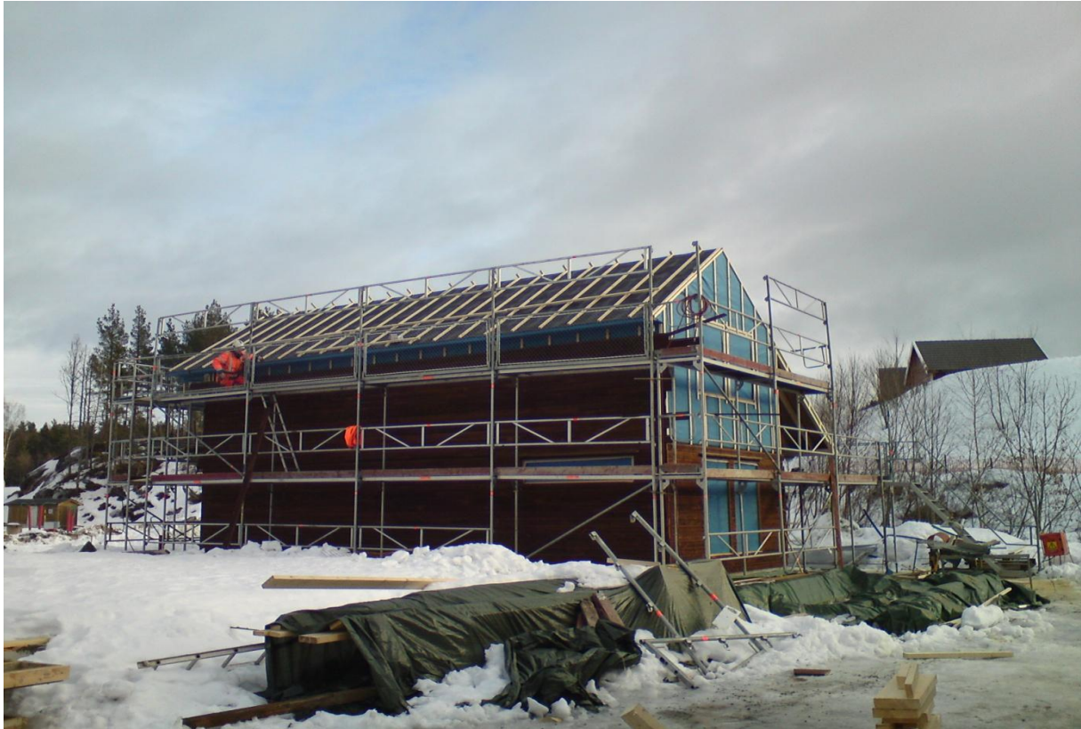
Figur 5-6. Arbeid i høyden medførte ekstra manuell transport av materialer.
