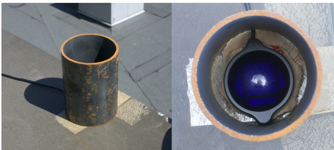
Figur 4-2: Plassering av stålrør over GPS mottaker
