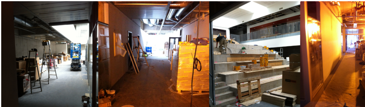
Figur 5.2: Innvendig fem dager før planlagt ferdigstilling
